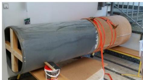
Die Litfaßsäule der Grundschule Habichtswald-Dörnberg im Entstehen – den Körper bildet der Rest eines großen Kunststoffrohres, das mit Korkplatten beklebt wurde. Fehlen nur noch die Bodenplatte mit Rollen und der Stromanschluss.
